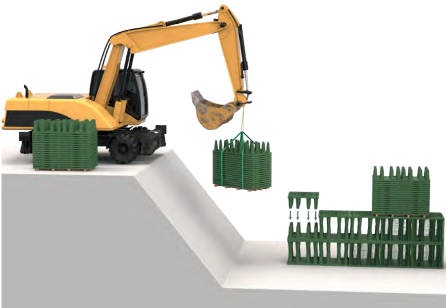
Montage dans la fouille
